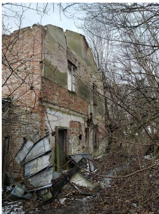
Fot. 2. Widok na dwór od strony północnej [fot. M. Dudkiewicz 2022] Photo 2. View of the mansion from the north [photo M. Dudkiewicz 2022]
