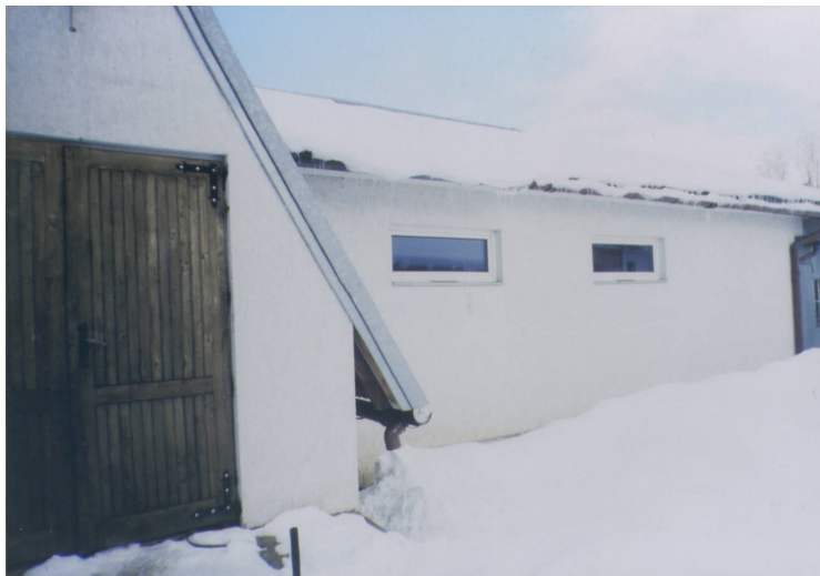
Rys. 1. Zamknięty obiekt fermowy w Bańskiej do kontrolowanego chowu ryb ciepłolubnych Fig. 1. The closed building for livestock in Bańska for the controlled warmwater fish's breeding
